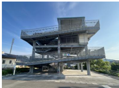
図 津波避難タワー
