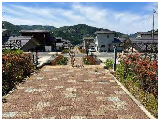
【宮城県】女川町の復興住宅団地
