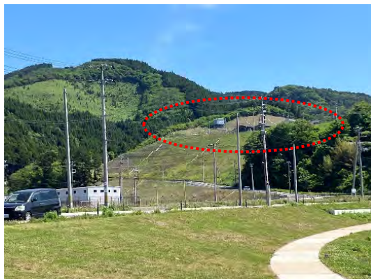
【宮城県】女川町の高台住宅
