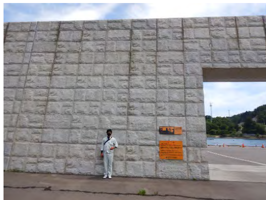
【宮城県】石巻市雄勝町の堤防(近景)
