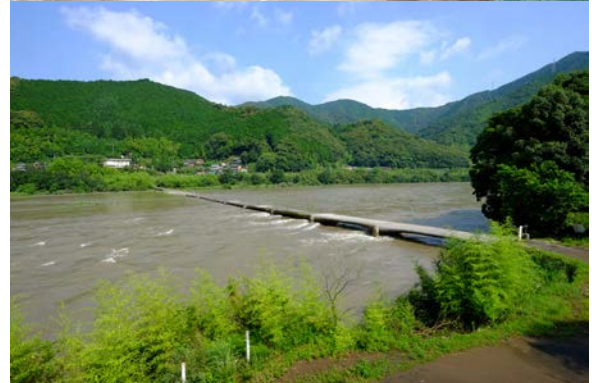
集落や農地への渡河を支えつつ、繰り返す増水をいなし沈下橋は、川とともに生きる文化の象徴的な要素である
