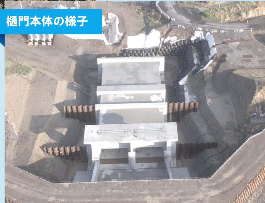
その後、堤防を開削し、地盤改良、遮水矢板を施工したあと、樋門本体の工事を行います。
