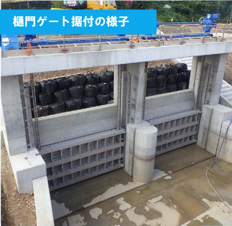
合わせて、樋門ゲートの据付や操作機器を設置する上屋工事をを行います。
