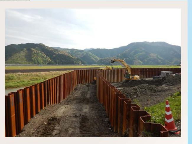
樋門工事に支障とならない位置に鋼矢板を二重で打込み、間に土砂を投入します。
