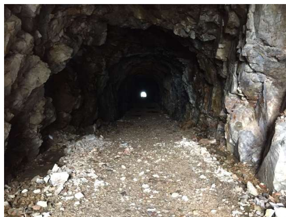
トンネル内状況
