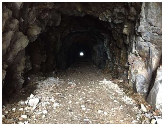
トンネル内状況
