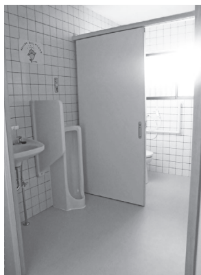
改修したトイレ
