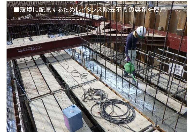
■鉄筋使用前の錆止め塗布
