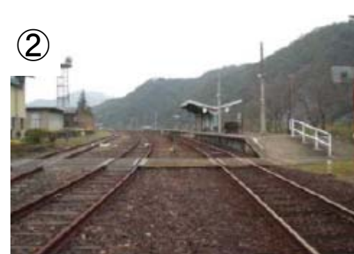
旧側線2番(窪川方より)
