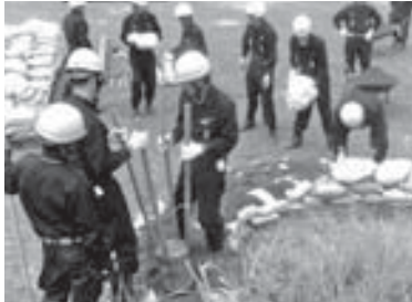
月の輪工(漏水対策)
