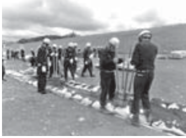
積み土のう工(越水対策)
