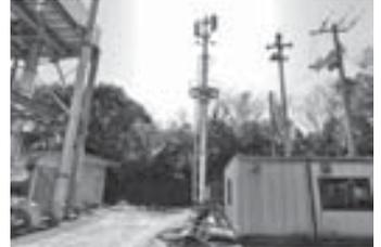
【具同配水池に設置したホーンアレイスピーカ】従来の3倍(約1km)の音達距離が可能となった
