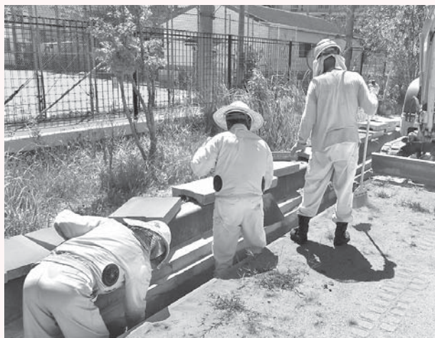
側溝清掃作業の様子
