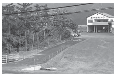
整備した避難路
