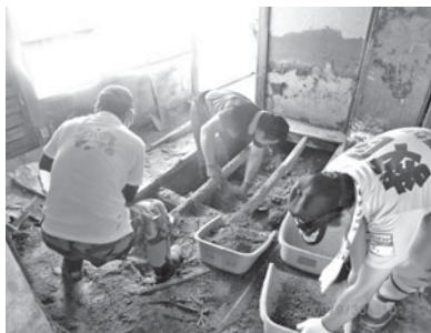
床下の土砂出し作業
