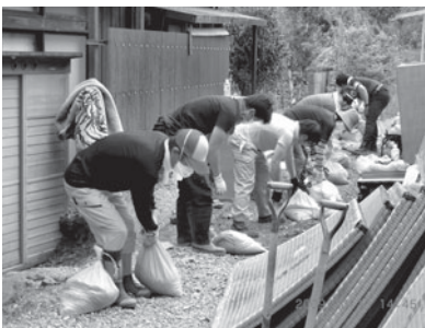
手渡しでの土のう袋の搬出作業
