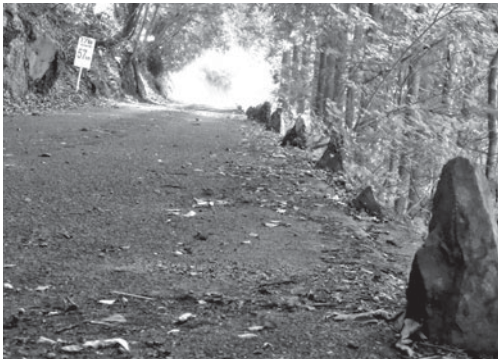
石のガードレール。縦に尖った大きめの石がアスファルトで固められ、約2メートルおきに埋められている。 (ウルトラマラソン57km地点ほか・半家)
