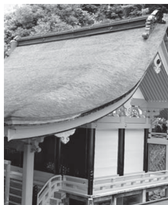
保存修理工事を終えた不破八幡宮本殿(東面)
