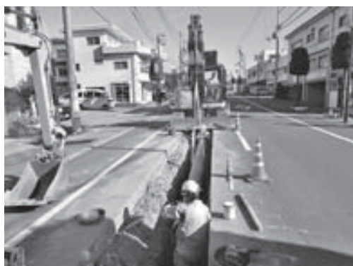
老朽管を耐震管に布設替
