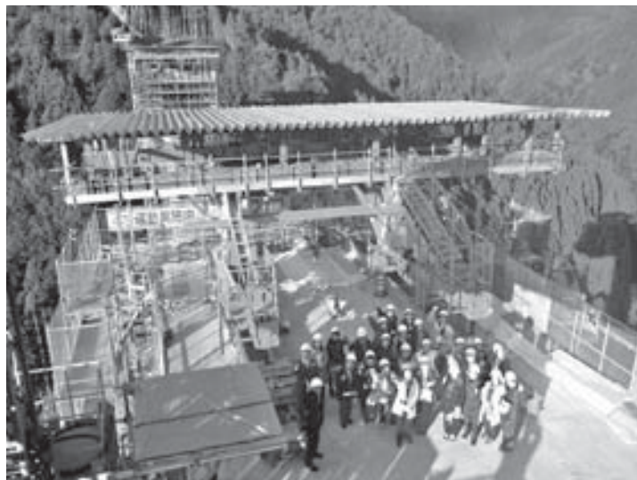
「高速道路建設ガンバロー」と決意を新たにしました。 片坂バイパス・市野瀬橋の橋脚建設現場(地上77.7m)にて
