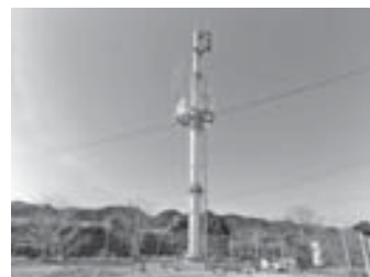
【ホーンアレイスピーカ】 従来の3倍(約1km)の音達距離が可能
