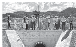
工事説明会の様子
