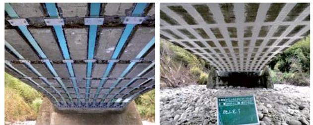
(アウトプレート工法で床板を補強・補修)
