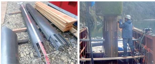
(鋼製当て板工法で橋脚を補強・補修)
