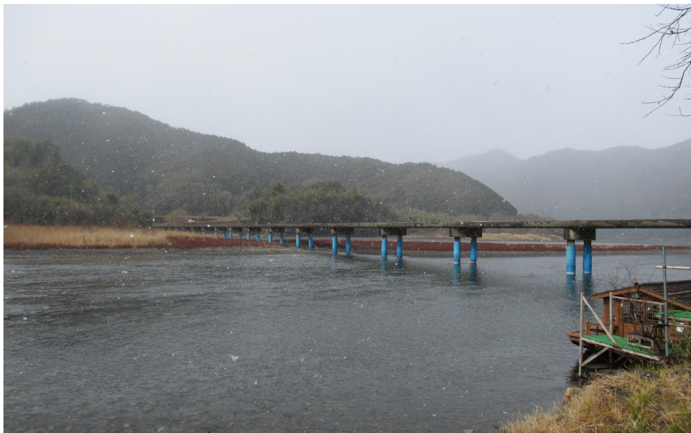
令和4年2月 雪と佐田沈下橋
