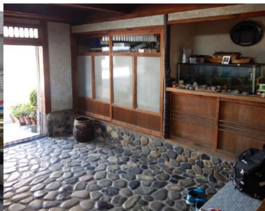
図4-2 四万十川の石を敷いた玄関土間
