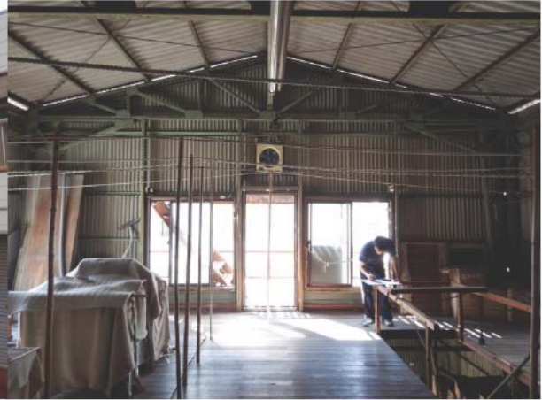
図4-16 鉄骨トラス
