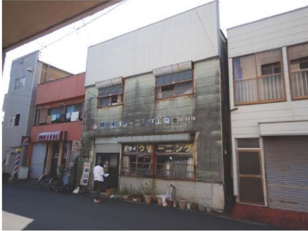
図4-15 朝日屋クリーニング工場外観
