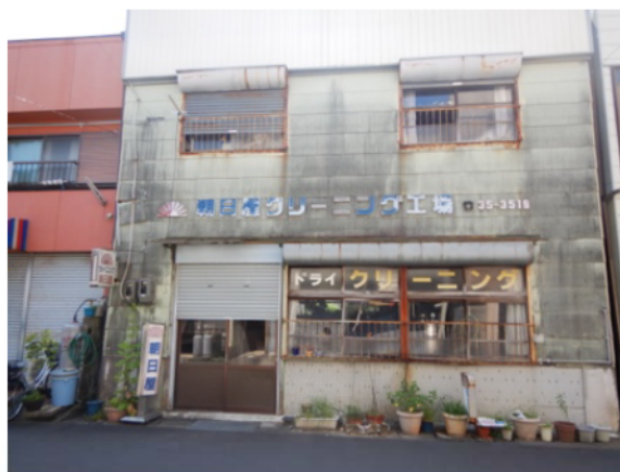
図3-14 看板建築の事例
