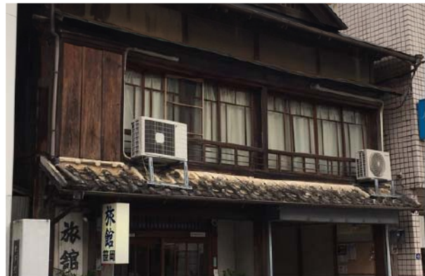
図3-17 2階に設置された欄干
