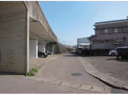
③北側道路
