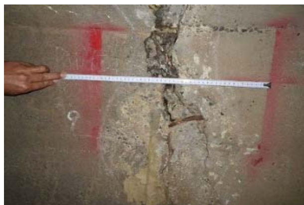
函渠内のクラック
