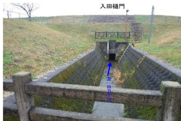
呑口側導水路
