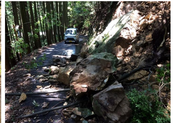
落石による通行止め
