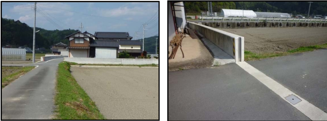
図 3.11 浸水防止壁のイメージ（他河川での事例）
