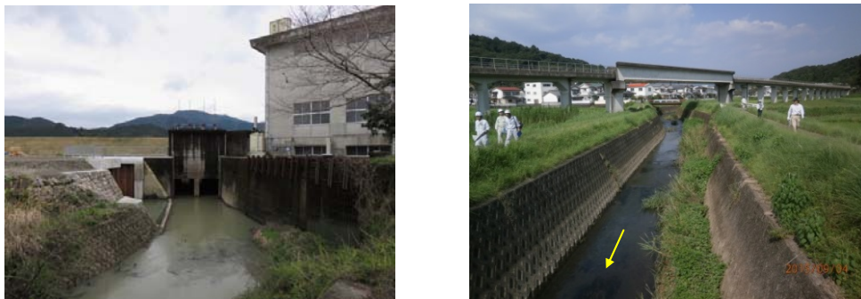
図 2.9 楠島排水機場・清水樋門（左）と相ノ沢川改修区間（右）
