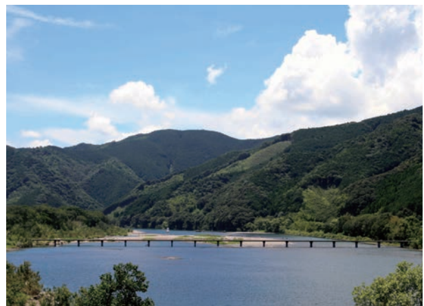
佐田の沈下橋
