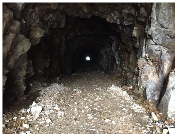
トンネル内状況
