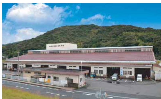
幡多公設地方卸売市場
