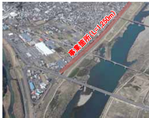
具同・入田箇所の堤防整備事業
