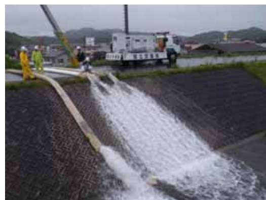
横堤樋門排水状況
