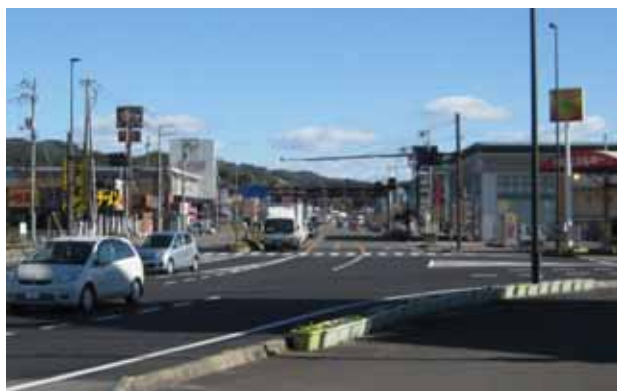
国道56号沿線状況（古津賀地区）
