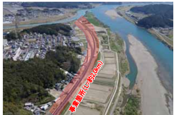
不破角崎堤防（平成 26 年（2014 年）度完成）
