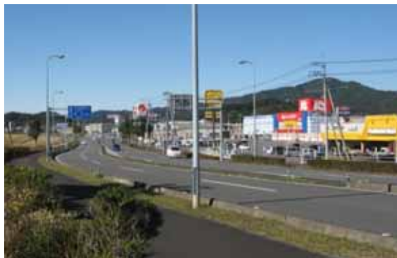
国道56号沿線状況（具同地区）
