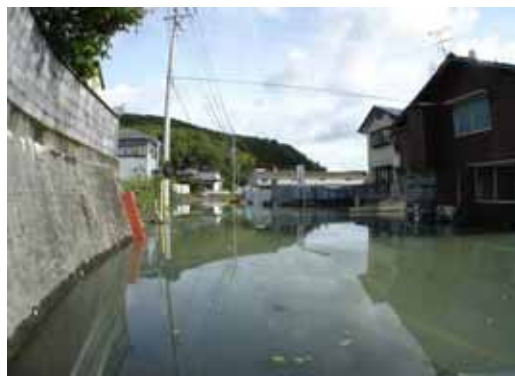
（百笑地区の内水氾濫状況）
