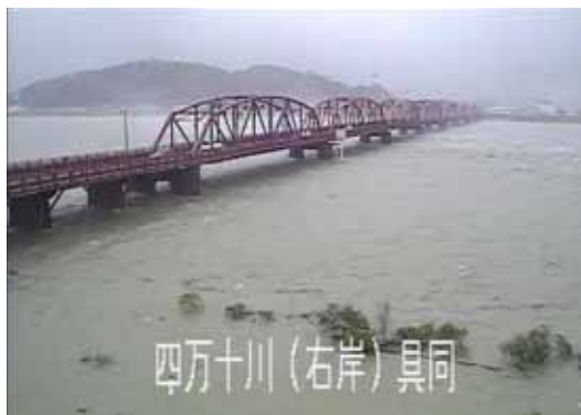
（赤鉄橋の外水による洪水状況）
