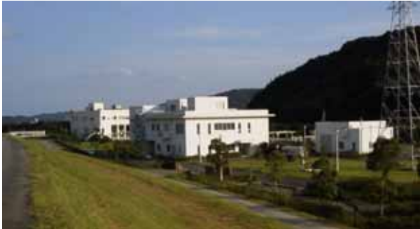
中央下水道管理センター（下水）
