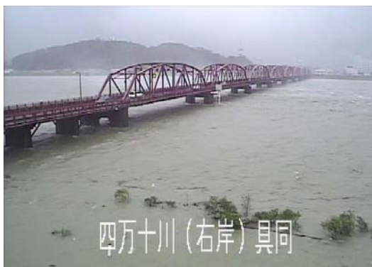
(赤鉄橋の外水による洪水状況)
