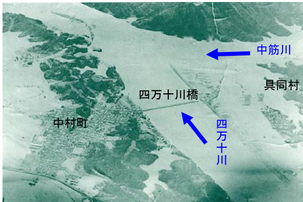
昭和 10 年 8 月洪水 (堤防決壊で浸水した具同村)
