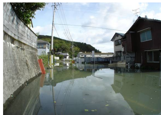
(百笑地区の内水氾濫状況)
