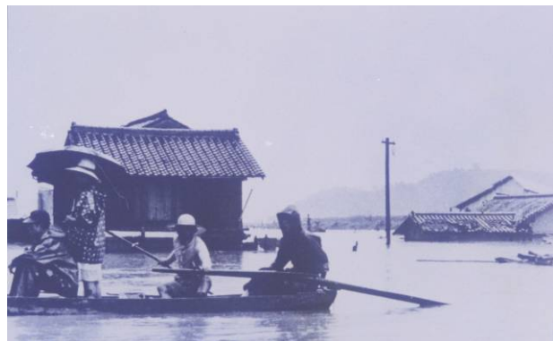
昭和 38 年 8 月洪水 (古津賀堤防決壊の状況)
