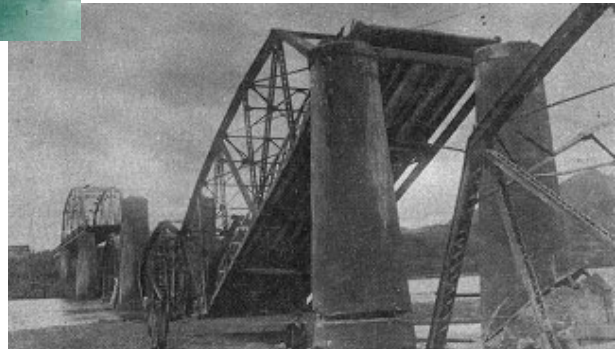
昭和 21 年 12 月 21 日 南海地震 (赤鉄橋の落橋)
