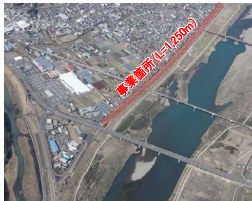
具同・入田箇所の堤防整備事業
