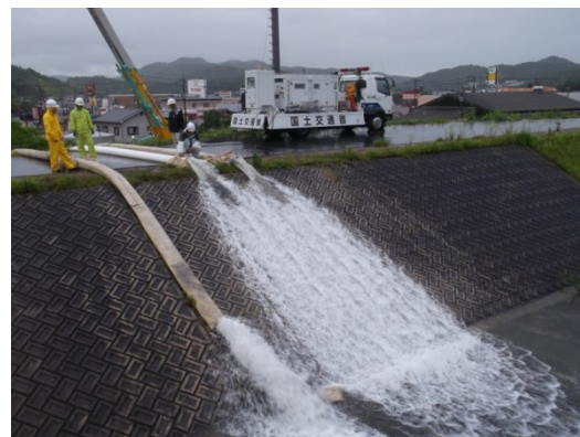
横堤樋門排水状況
