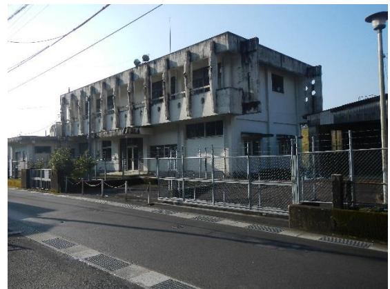
図表 2-12 百笑旧水道課庁舎（電気室及び管理室庁舎）
