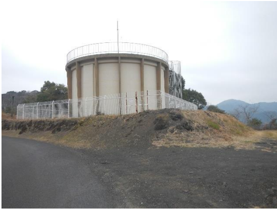
図表 2-11 丸の内ハイランド配水池
