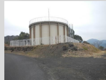
丸の内ハイランド配水池
