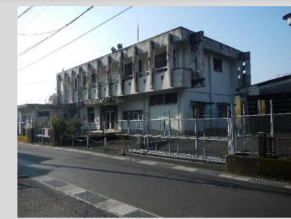
百笑旧水道課庁舎 (電気室及び管理室庁舎)
