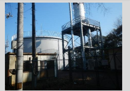
具同配水池及びばっ気塔
