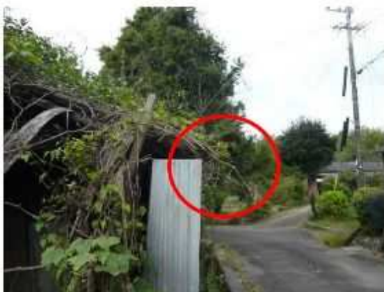
枝等が道路にはみ出している
