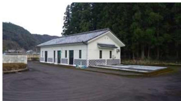
図表 2-17 森沢農業集落排水処理施設 (森沢クリーンセンター美沢)
