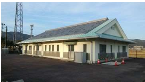
図表 2-16 古津賀農業集落排水処理施設 (クリーンセンター古津賀)
