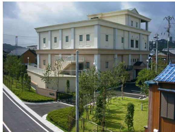
図表 2-15 桜町排水ポンプ場
