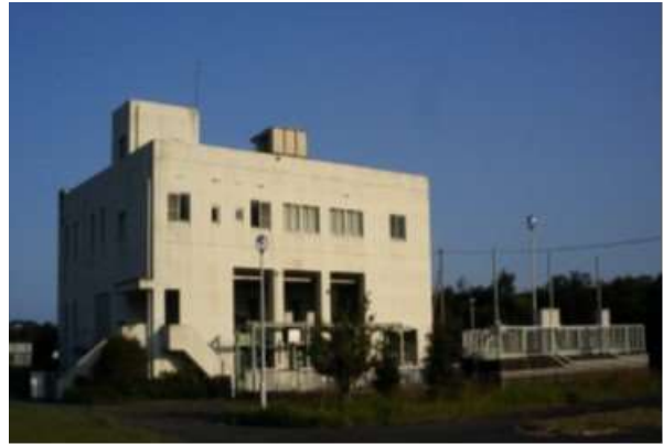
図表 2-13 右山排水ポンプ場
