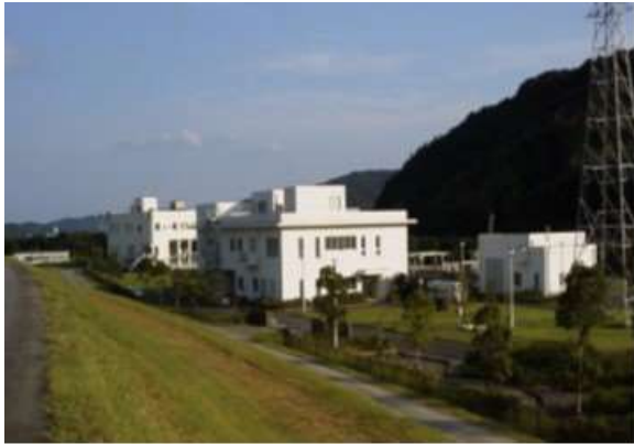
図表 2-12 中央下水道管理センター
