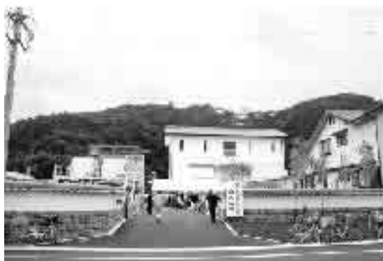
7月7日に通水式が行われた百笑排水ポンプ場
