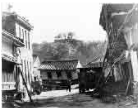
旧中村町内では全家屋の9割が倒壊した(京町1丁目)
