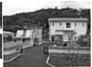
百笑雨水ポンプ場 市街地四つのポンプ場のうち平成18年6月に完成しました。台風時や、豪雨のときに威力を発揮します。
