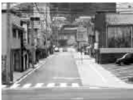
新しく生まれ変わった町冲通線 (中村警察署前通り)
