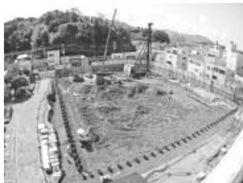
新庁舎工事現場(10月8日撮影)
