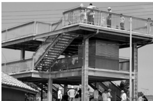
これで安心。立派な津波避難タワー
