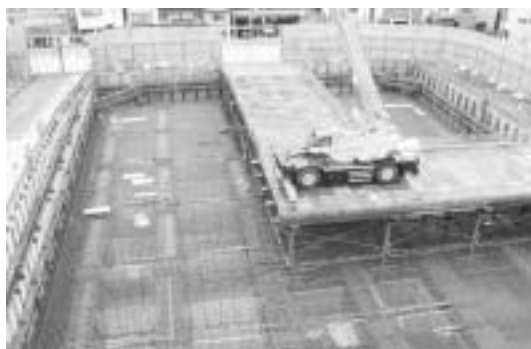
現庁舎屋上より
