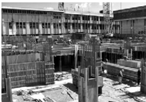
▲地下1階部分の型枠、鉄筋工事施工中
