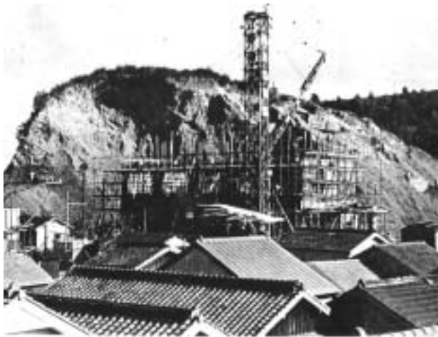
旧庁舎建設工事(敷地造成のための天神山の切り取り工事と議事堂建設工事(手前。)(昭和31年頃)
