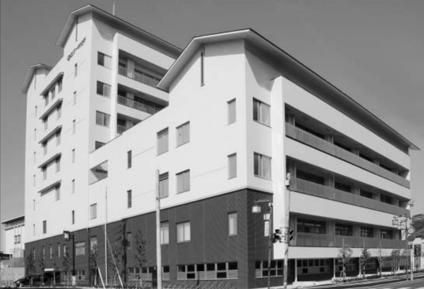
落成した新庁舎(正面玄関側〔東側〕は外構工事の仮囲いが施されているため西側から撮影)
