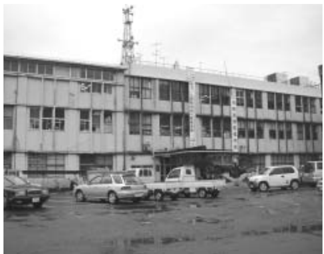
間もなく旧図書館とともに解体される旧庁舎(平成18年撮影)
