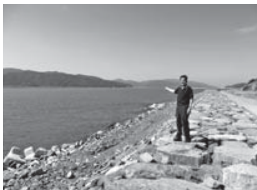
北上川河口(左岸、防波堤復旧中)
