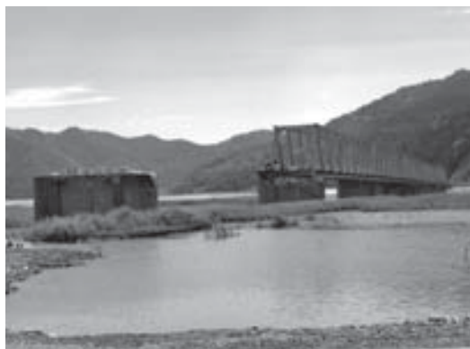
新北上川大橋流出 右岸上流4km
