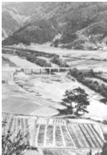
久栄岸橋(大正末年) 右奥が現在の佐岡地区
