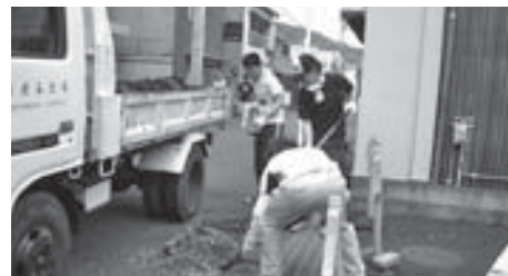
ダンプ45台分の土砂を回収しました
