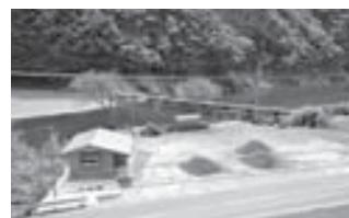
完成した四万十茶屋(岩間沈下橋左岸側)
