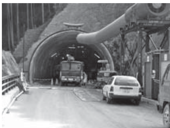
国道441号 川登工区(24年度開通予定)
