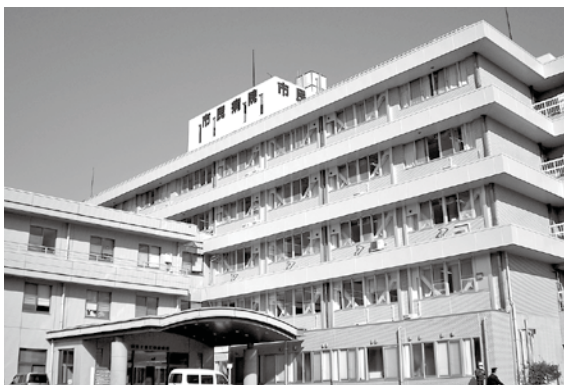
外壁も補修し、きれいになりました。
