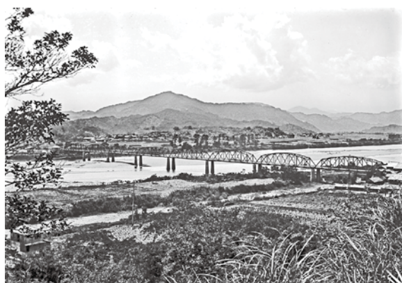
完成間もない頃の赤鉄橋(昭和初期)
