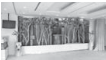
市役所庁舎玄関改修
