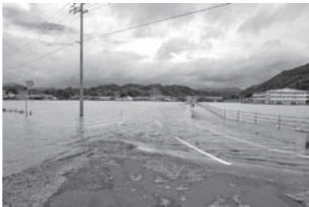
台風11号により冠水した安並地区
