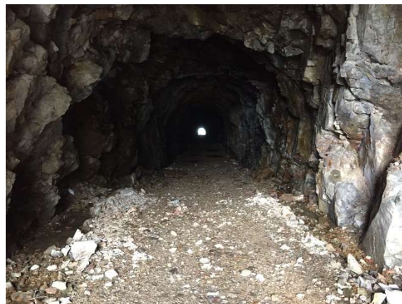
トンネル内状況
